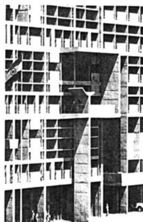
Schermatura fissa quale elemento architettonico di facciata
